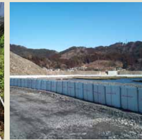
連続した止水壁の構築
